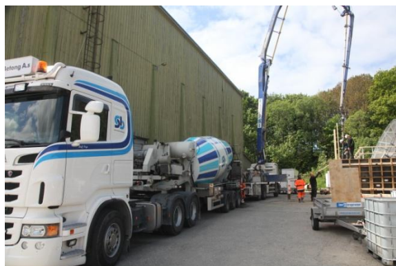
Fra bygging av tanken
