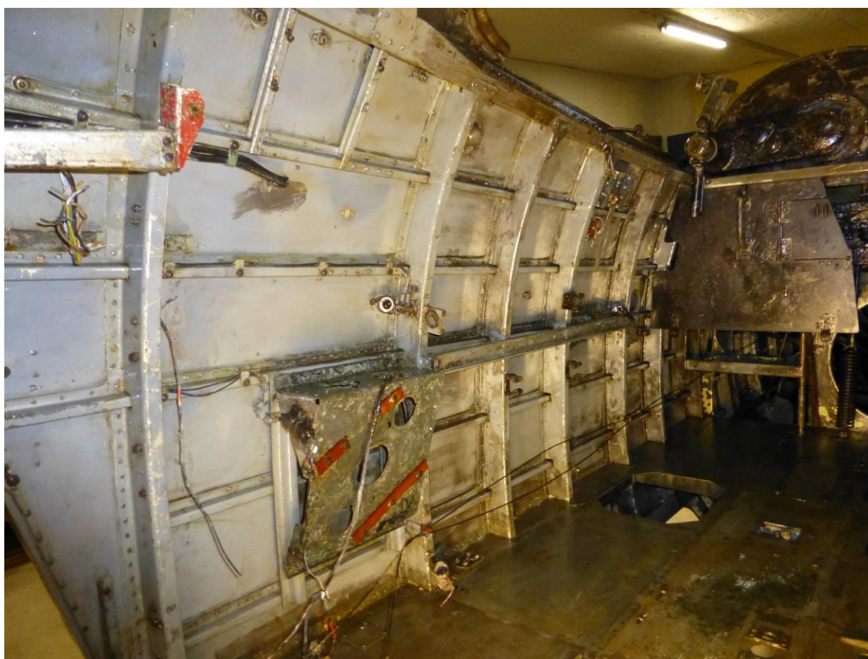
Bilde 28. Cockpit etter konservering
