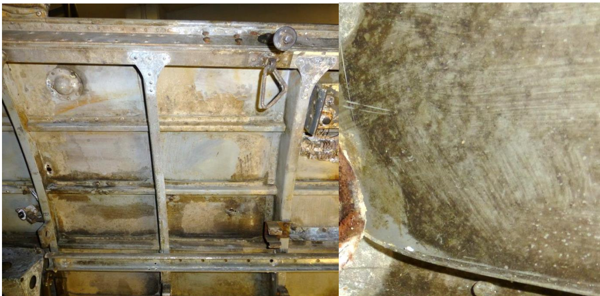
Bilde 12. Skroget har fått behandling med et voks eller oljebasert korrosjonshemmende middel da det var i bruk. Man ser penselstrøkene i dette middelet.
