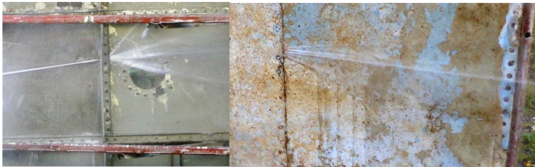
Illustrasjon av verktøyet en vil benytte til høytrykk spyling med varmt vann av plateskjøter
