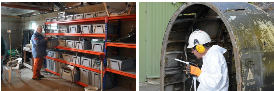
Til venstre det er satt opp hyller i tanken for lagring av demonterte smådeler. Til høyre fra tørrisblåsing
