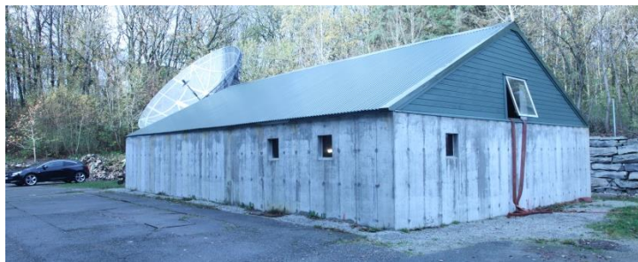
Tanken etter at taket er bygget
